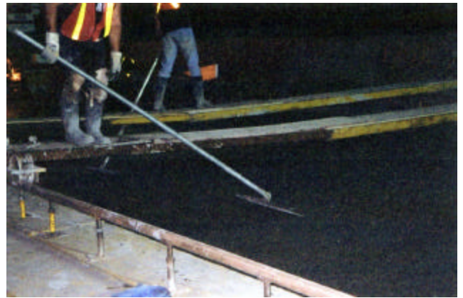
20-18 Night deck pour
