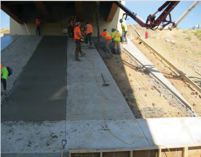
4.115 Pouring fill-in courses.
