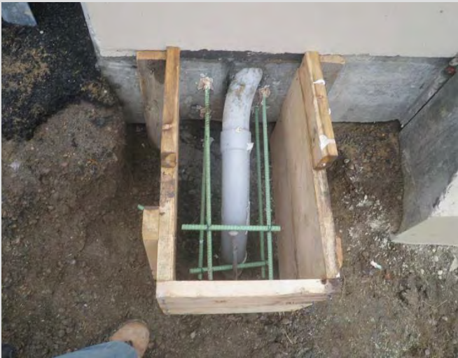
11.3 Electrical conduit exiting barrier.
