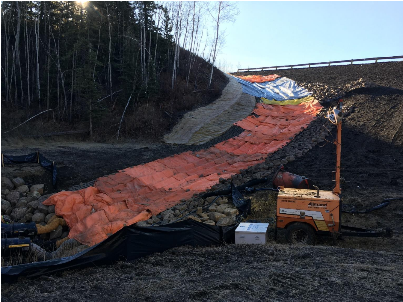
Site 3 – Heating/hoarding ACB mat area prior to grout pour
