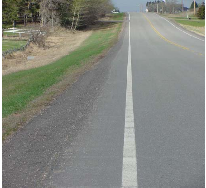
HD-21A, S. edge line looking west
